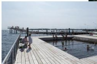
4. Строительство лодочного причала
