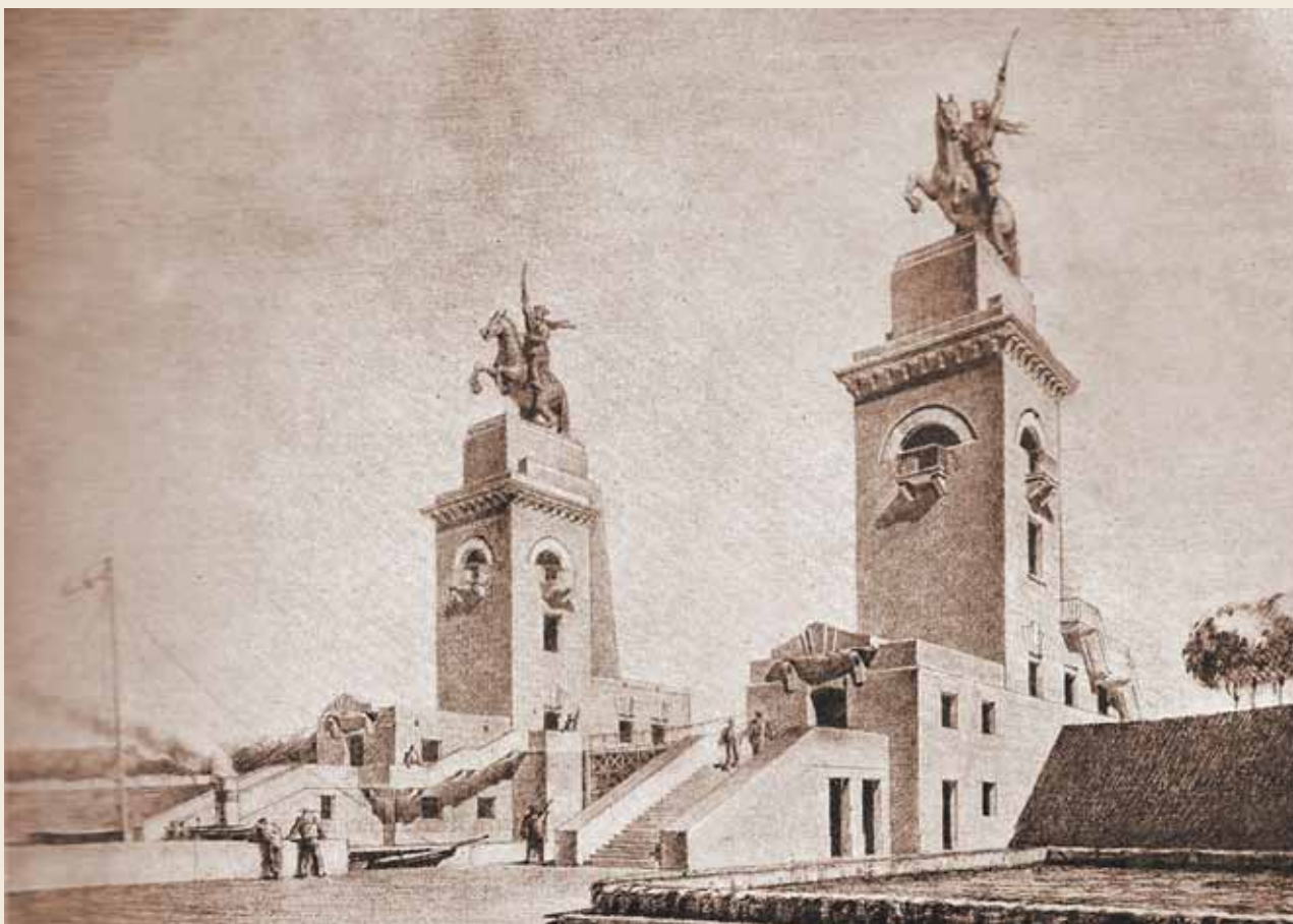
Здание управления нижней головы шлюза № 15. Вид со стороны нижнего плёса Дона
