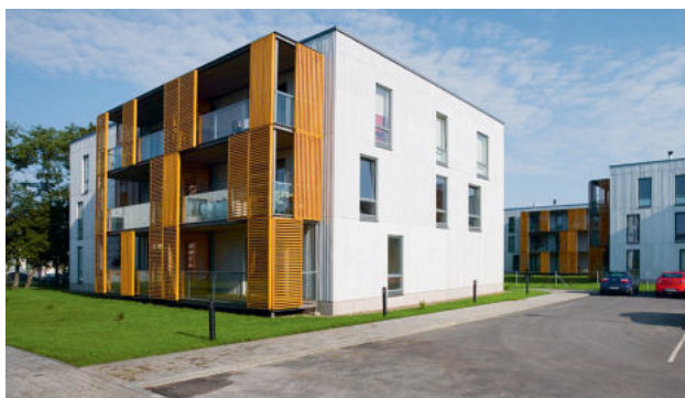
Таллин, Эстония © JVR Arhitektuuribüroo
