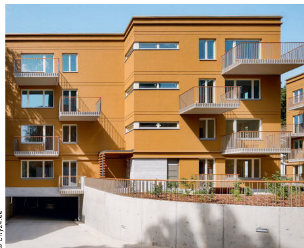
Въезд в подземную автостоянку Jakobsoni 7 apartment building (Таллин, Эстония)
