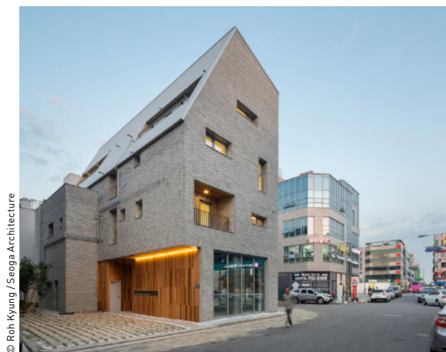
Входная группа с подсветкой в нише Guwol Multi-Family House (Инчхон, Южная Корея)
