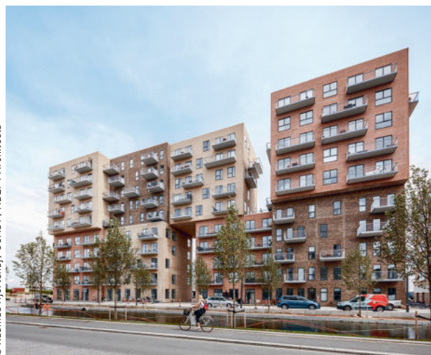
Секции дома расположены со сдвигом относительно друг друга Cubic Houses (Копенгаген, Дания)
