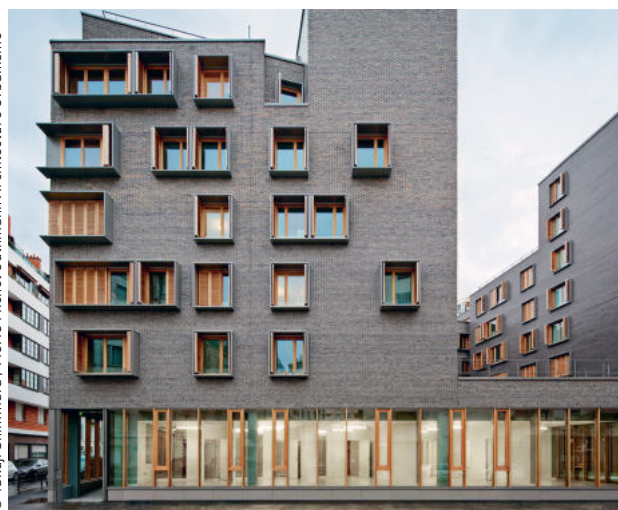
Фасад первого этажа выделяется на фоне остальных и служит визуальным акцентом ZAC Boucicaut (Париж, Франция)
